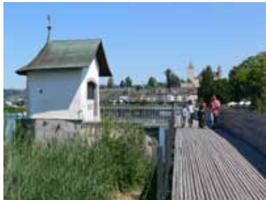
Passarelle en bois
